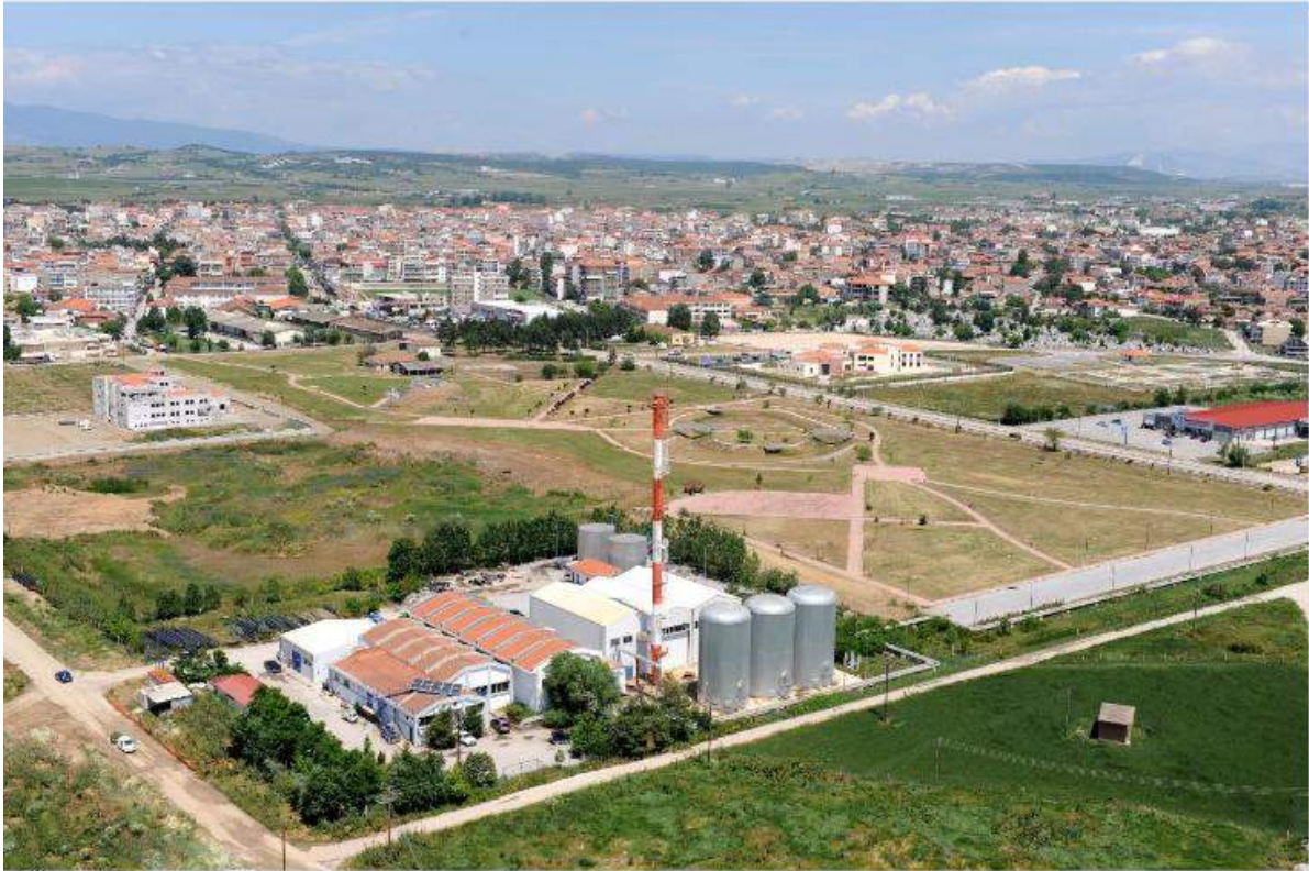
Εικόνα 1.2: Κεντρικό Αντλιοστάσιο Δημόσιας Επιχείρησης Τηλεθέρμανσης Πτολεμαΐδας (ΔΕΤΗΠ) στη νότια είσοδο της Πτολεμαΐδας 2
